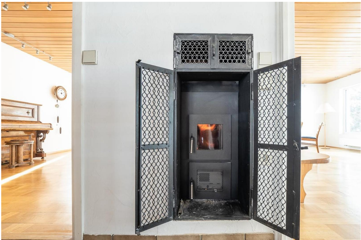
Holzfeuerung mit Sichtfenster
