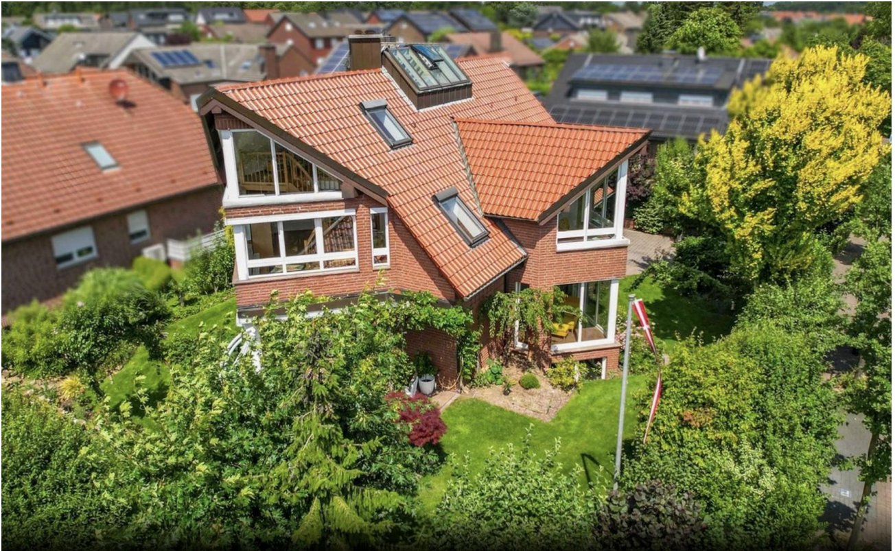
Ansicht aus Richtung Süd-West
