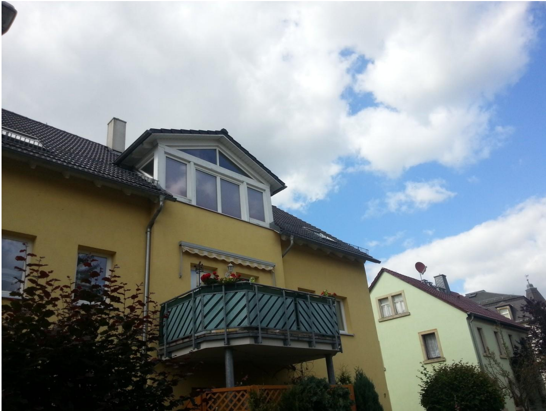
Blick von der Straße zur Wohnu
