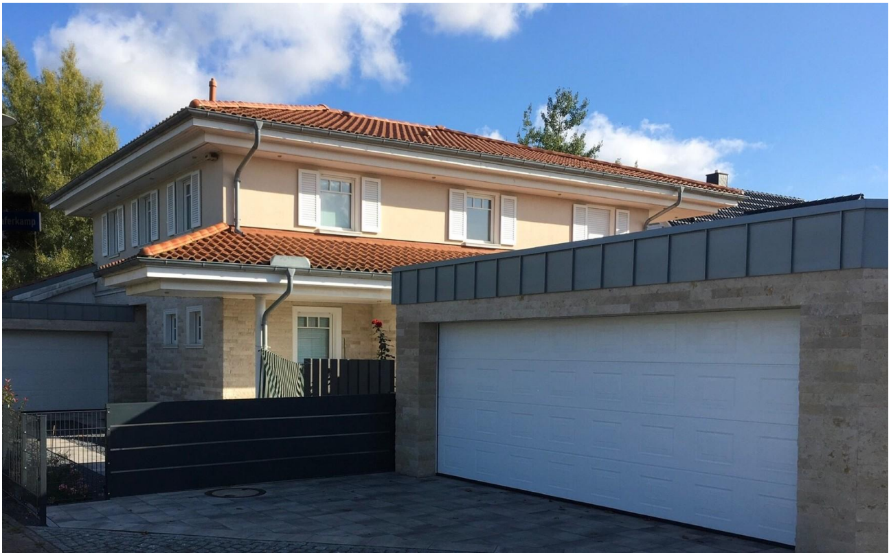
Garage II / Auffahrt (1)
