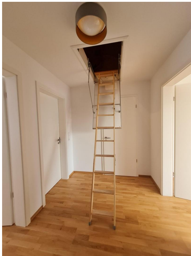
OG Einschubtreppe zum DG
