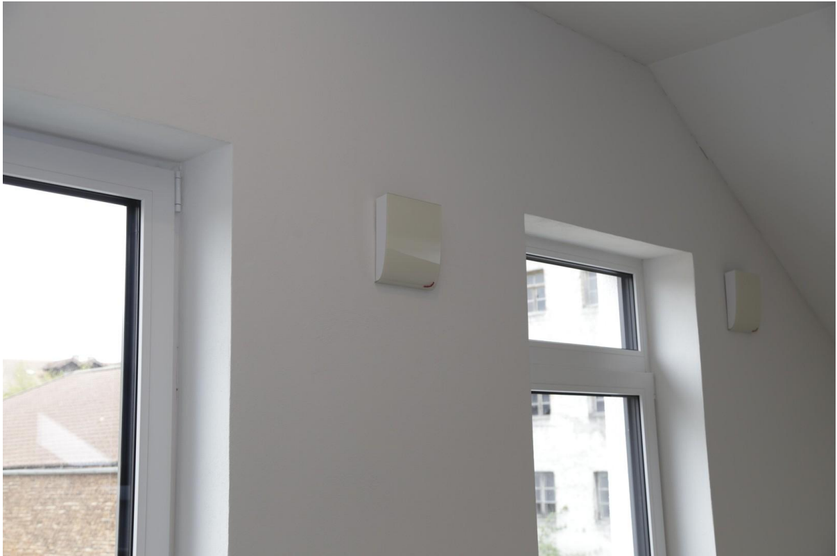
Kontrollierte Wohnraumlüftung
