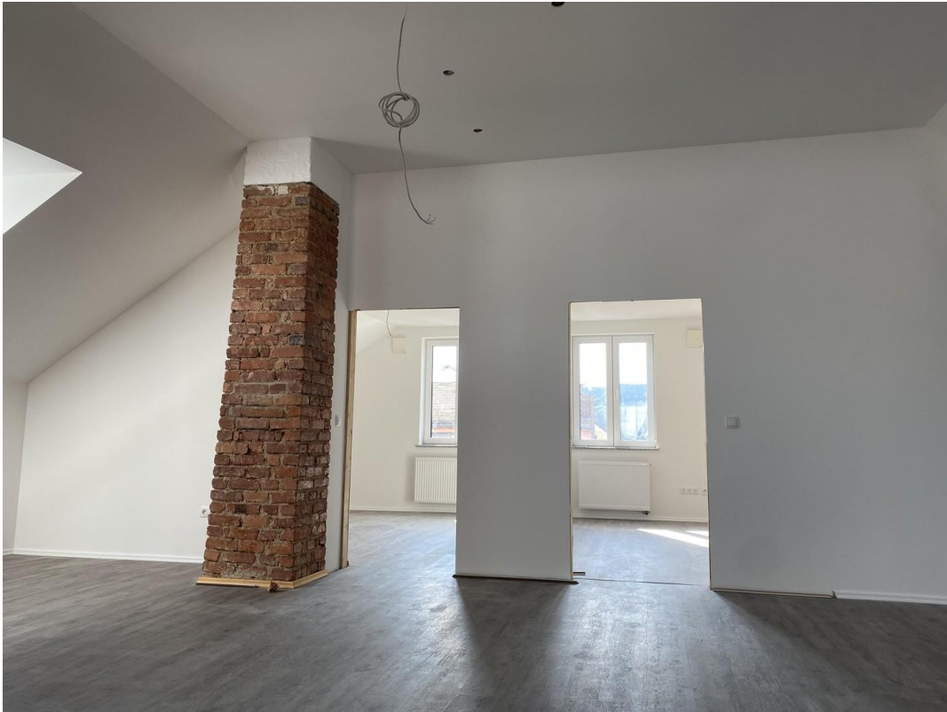
restaurierte Türen kommen noch
