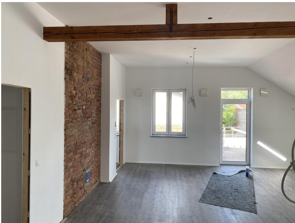
Kamine als Sichtziegel
