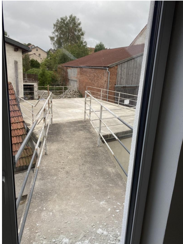
Brücke - wird noch saniert
