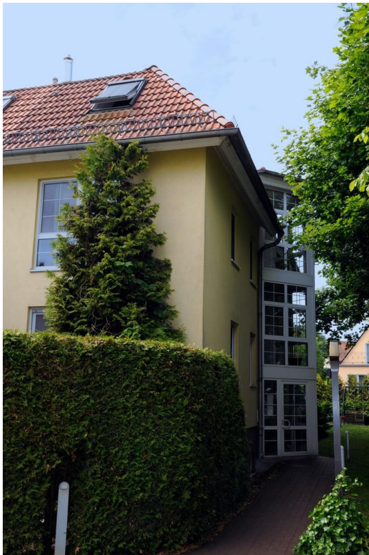
Blick auf den Eingangsbereich
