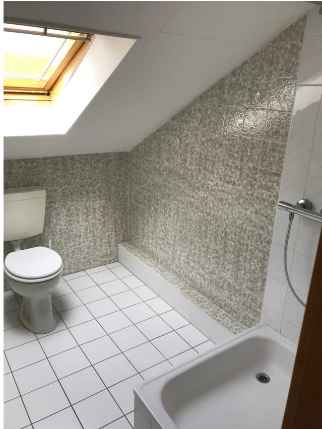
OG N Bad - Blick nach NO
