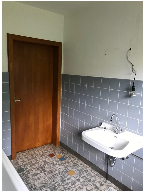
EG N Bad - Blick nach SW
