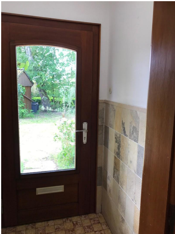
EG S Windfang - Blick nach S
