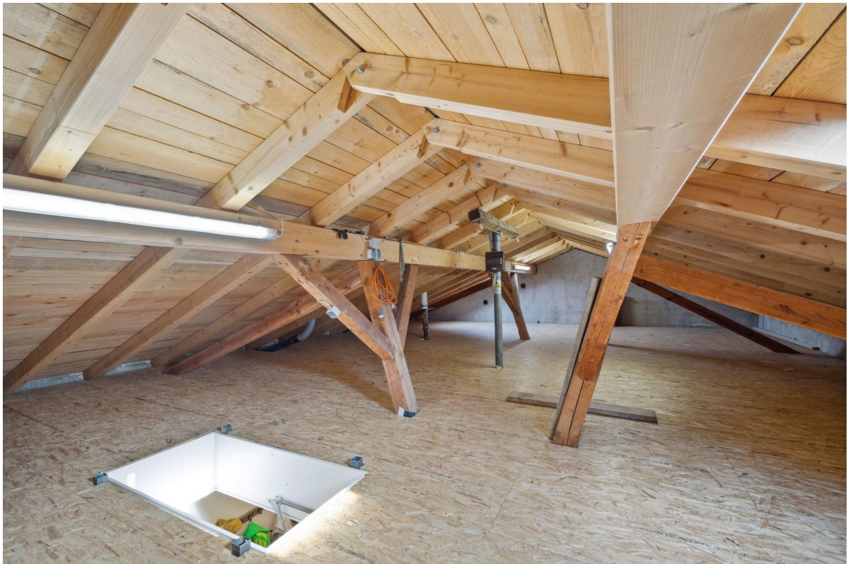
Dachboden Betondecke gedämmt
