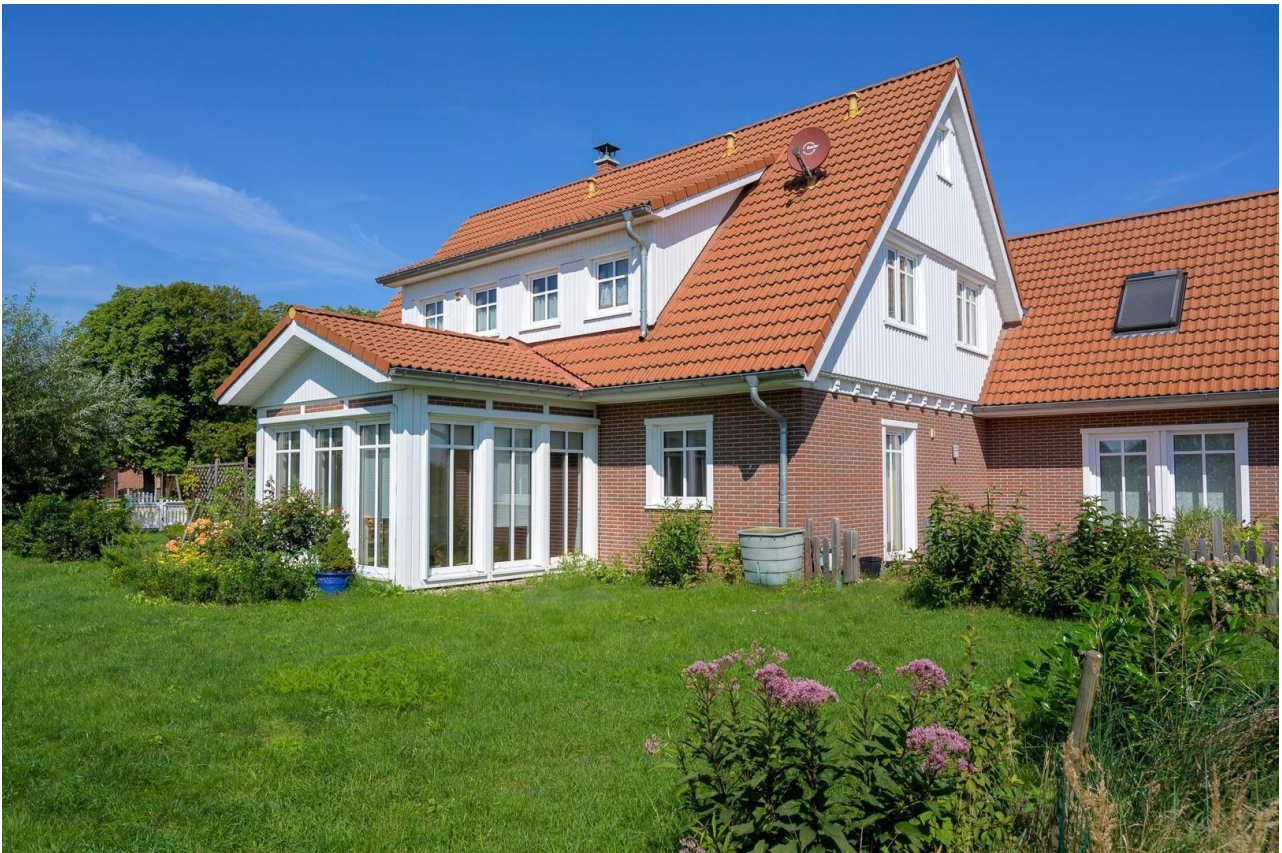
Aussenansicht mit Anbau 1
