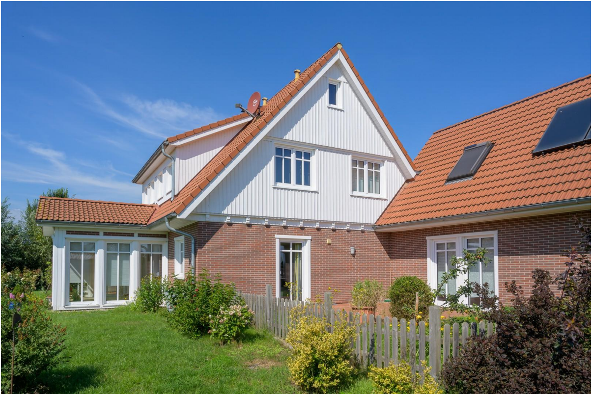
Aussenansicht mit Anbau 3
