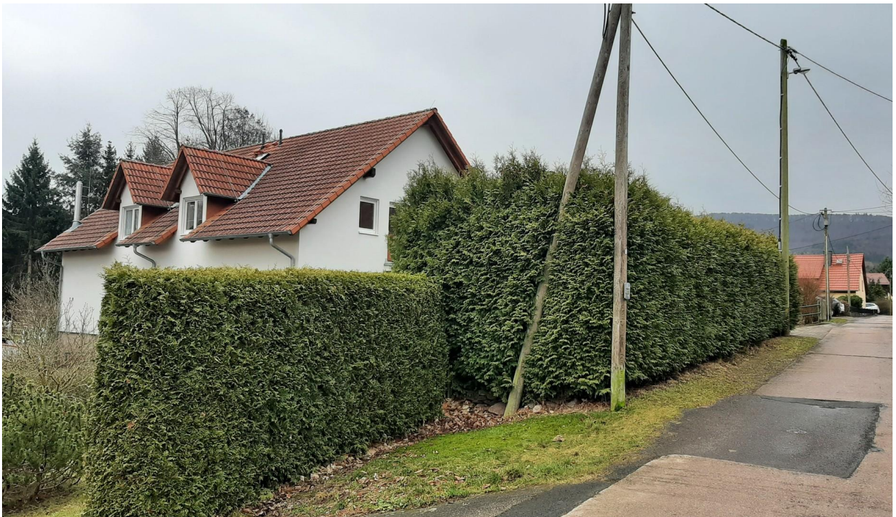
Blick von der Straße
