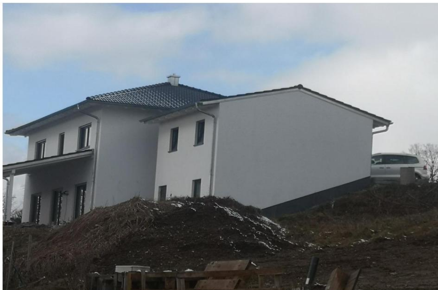
Rechte Nachbarbebauung / die Aussenanlagen werden aktuell begonnen
