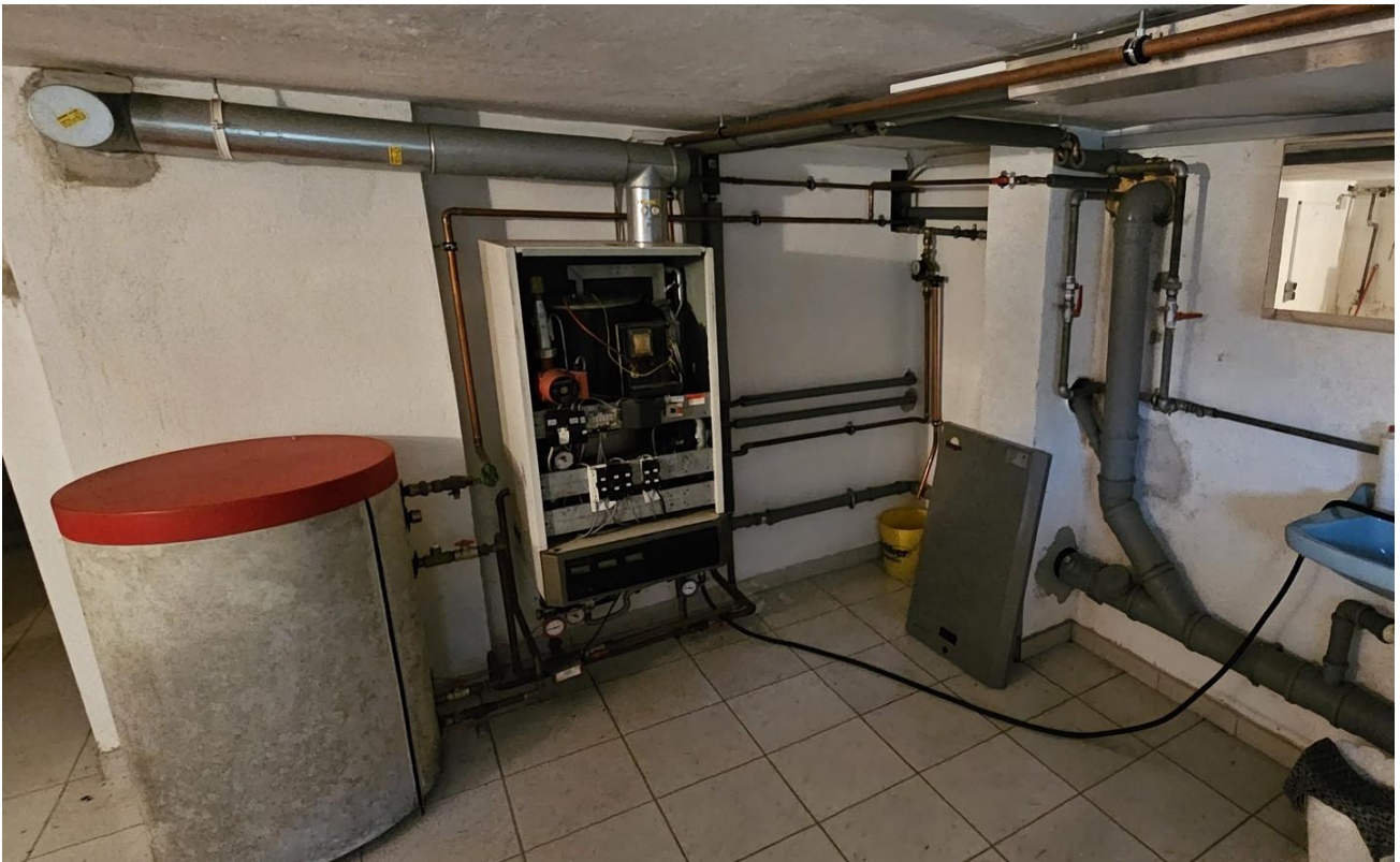
gefliester Keller Heizraum
