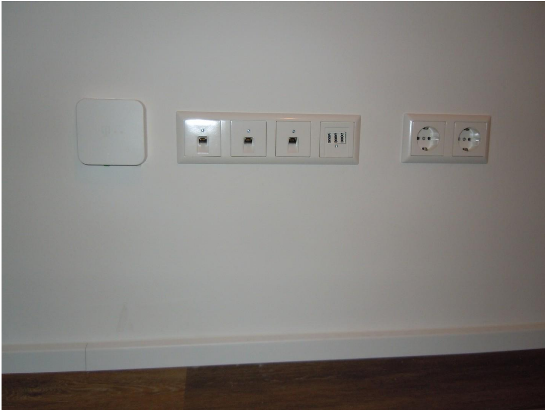
Glasfaseranschluß
