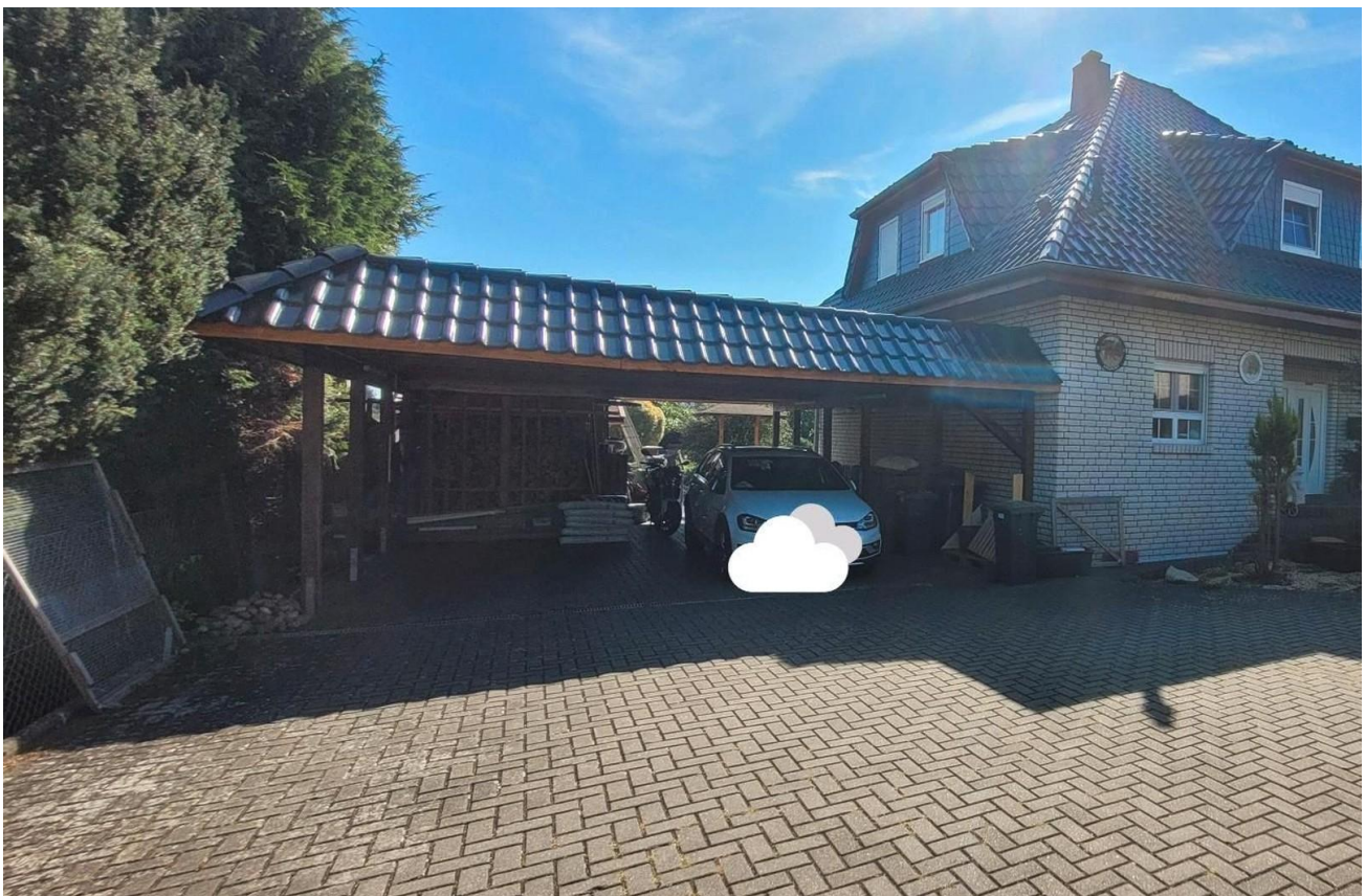
Frontansicht mit 4er Carport
