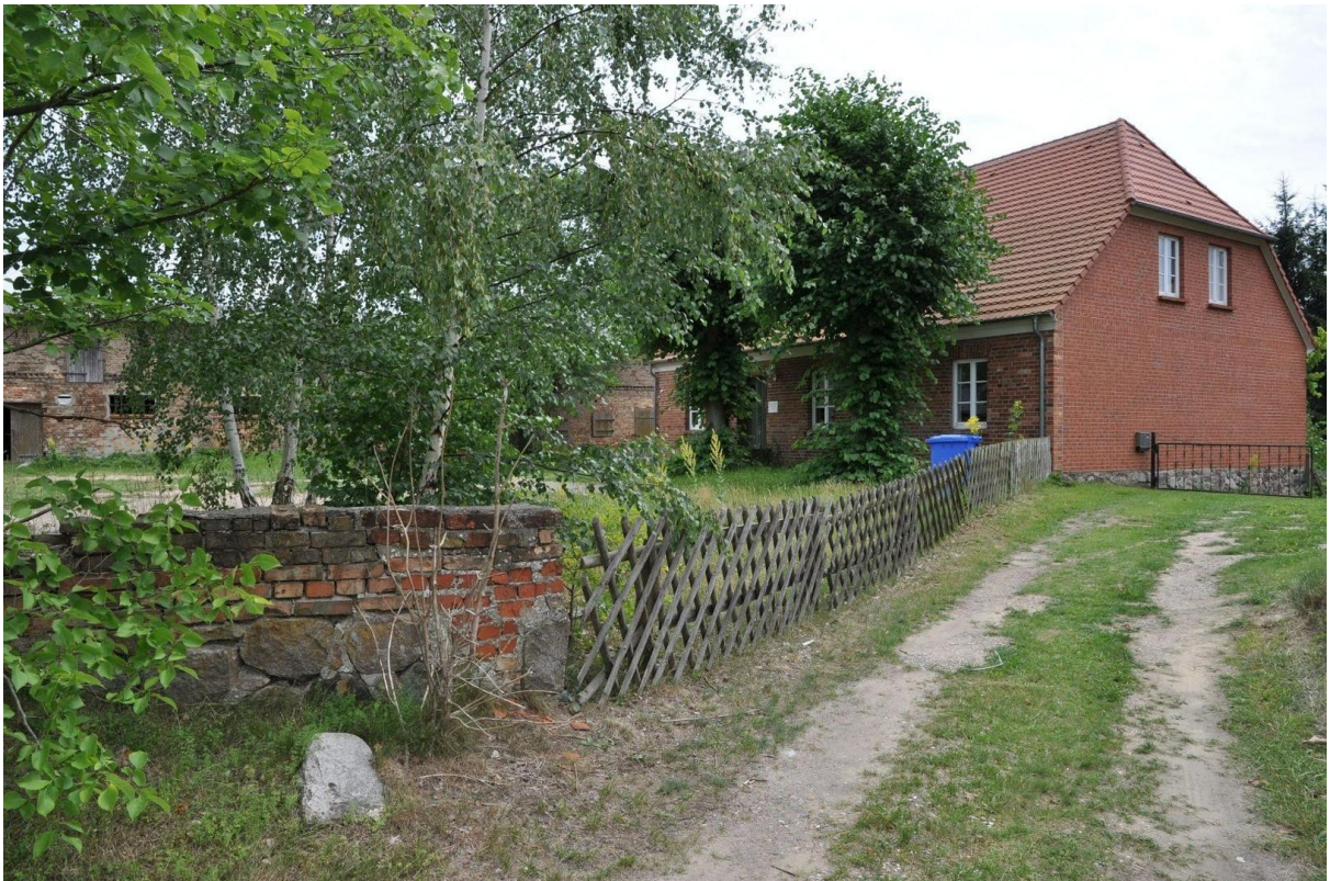
Blick von der Straße
