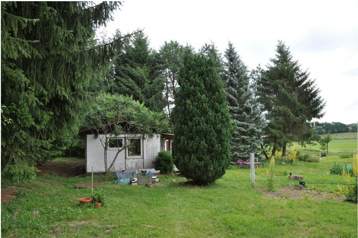
Seitenansicht der Laube
