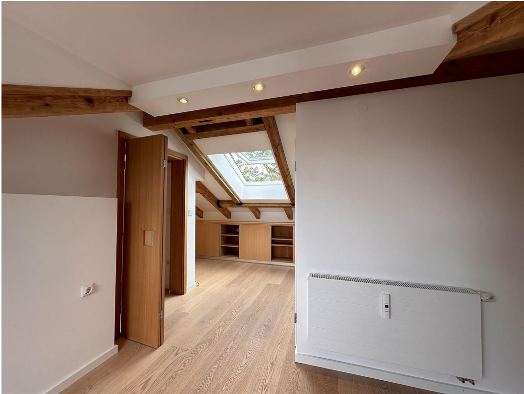
Arbeiten / Zimmer DG
