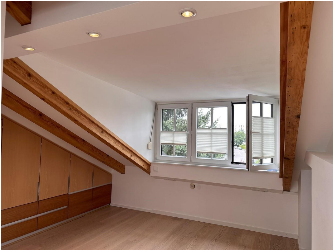
Arbeiten / Zimmer DG
