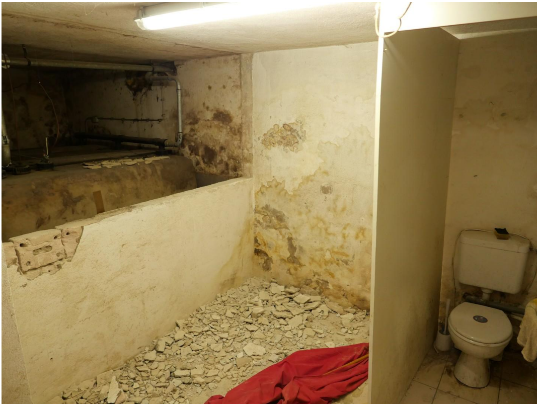
UG mit Öltank und Bau WC
