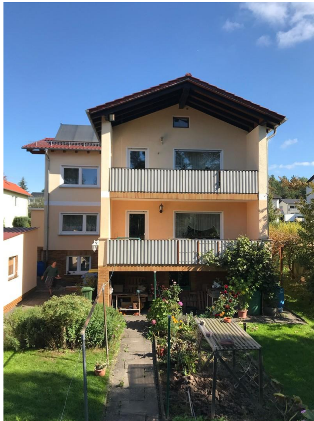
Ansicht Südseite mit Balkone
