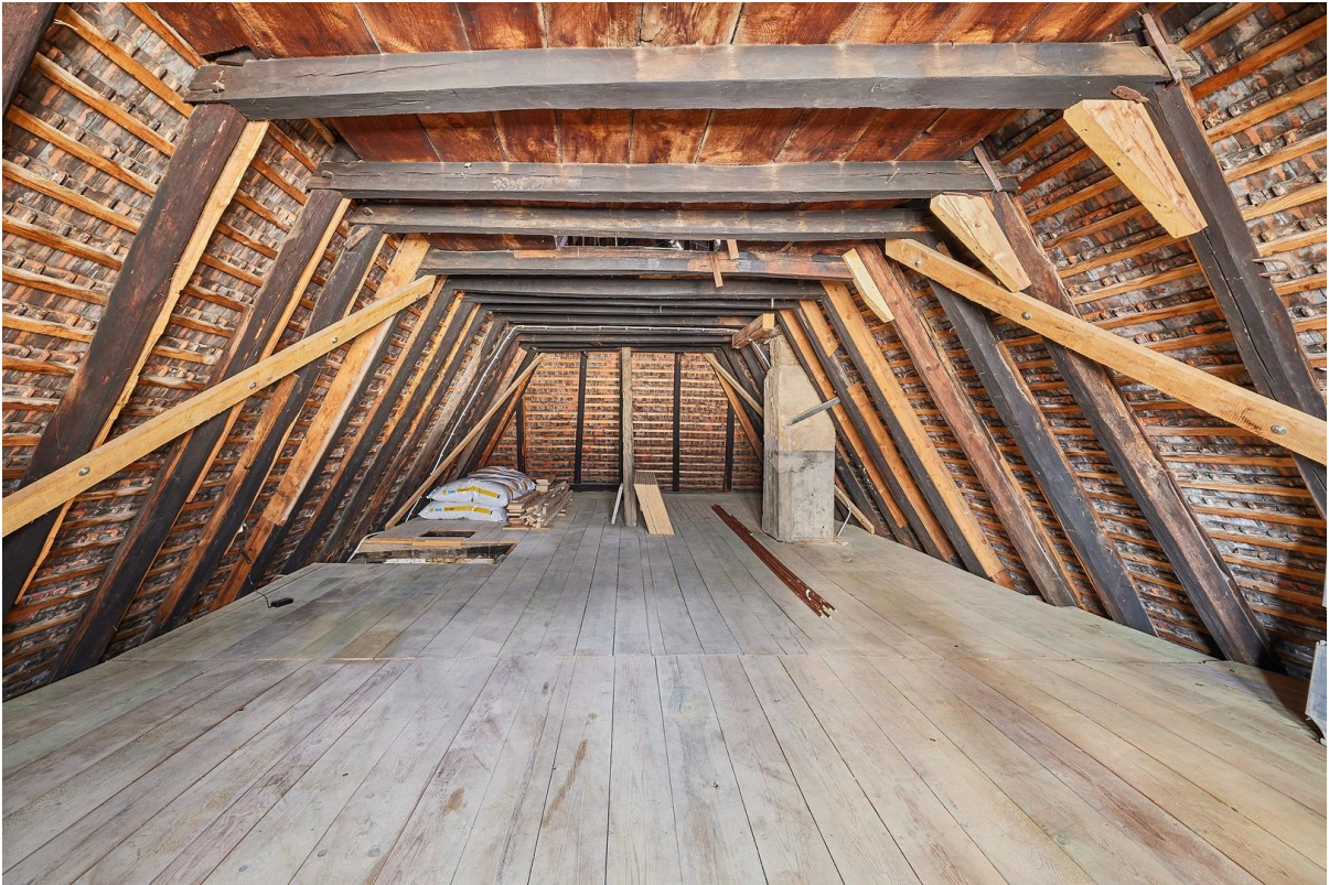
3.OG Dachboden Bild a
