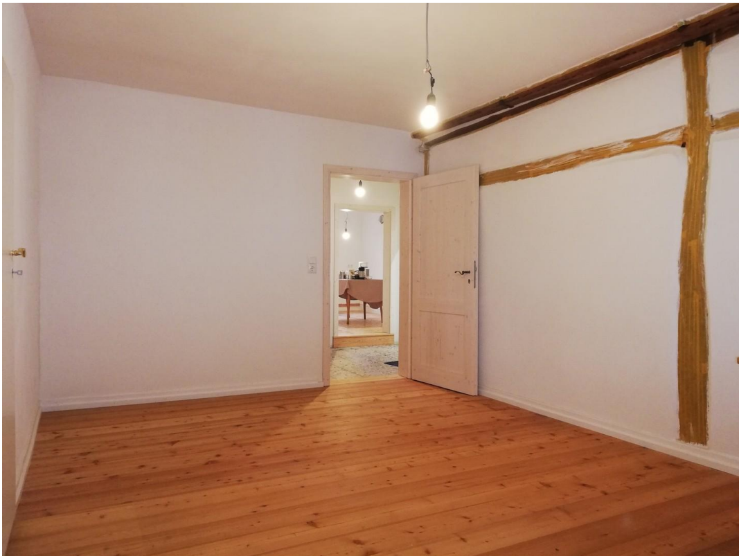
2.OG Raum O2SO Bild b
