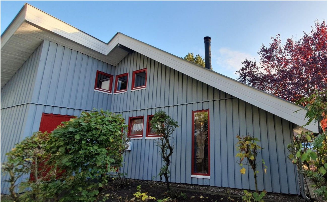
Eingangsbereich Haus Rückseite
