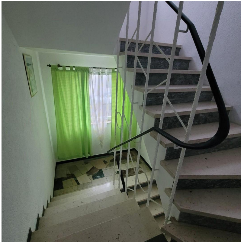
Treppe ins DG
