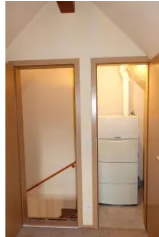
Blick vom Fenster Raum „Dachstudio“ zum Ausgang / Heizungsraum
