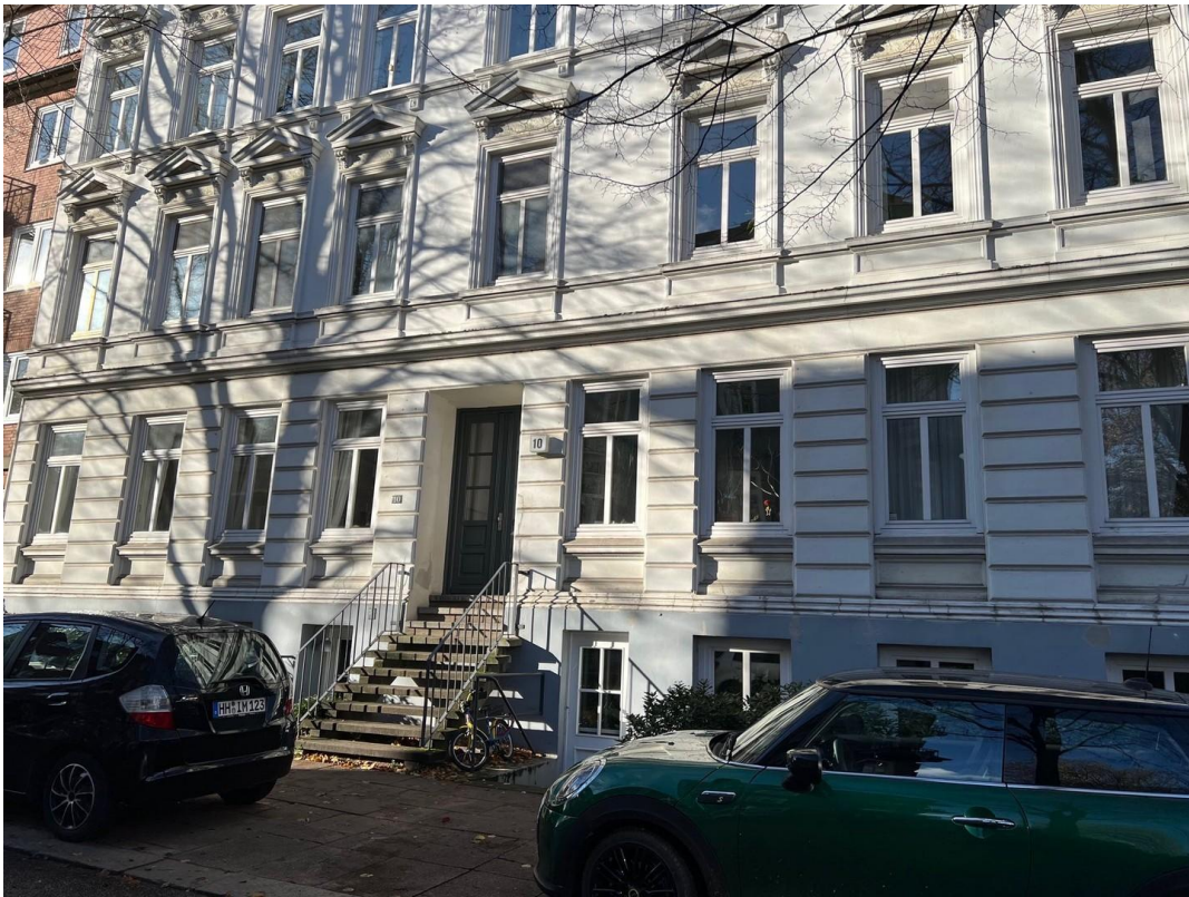
Fassade Haus zur Emilienstraße
