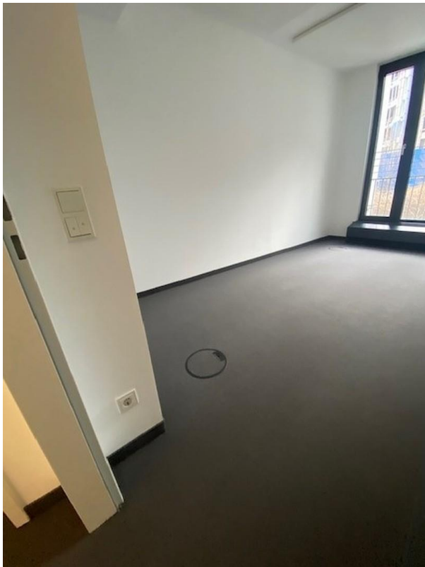
Bürofläche 1.OG Raum 1
