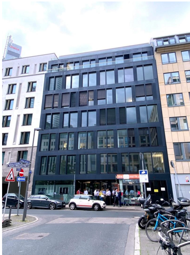
Ansicht Bürogebäude Front
