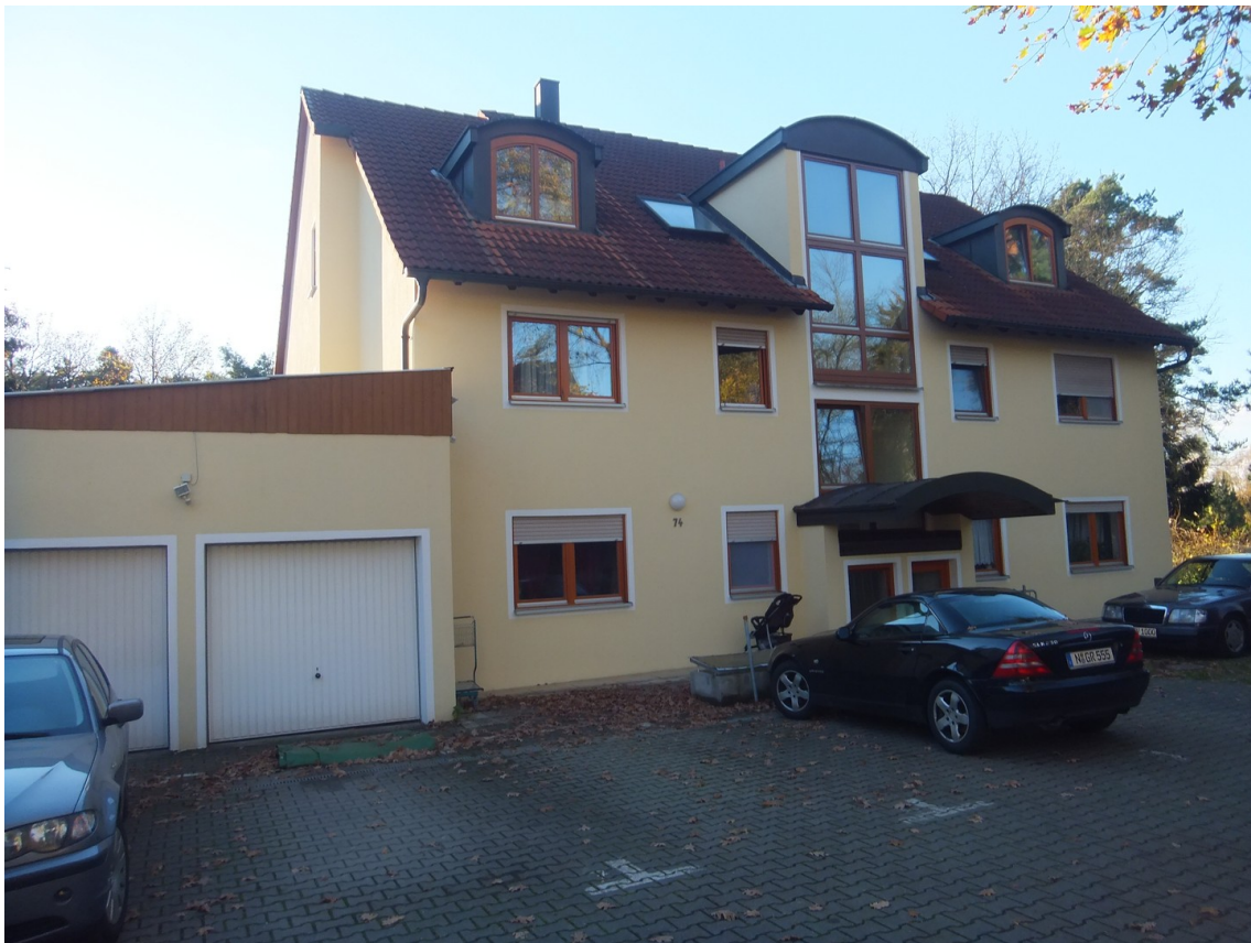
Whg. oben links, Garage rechts
