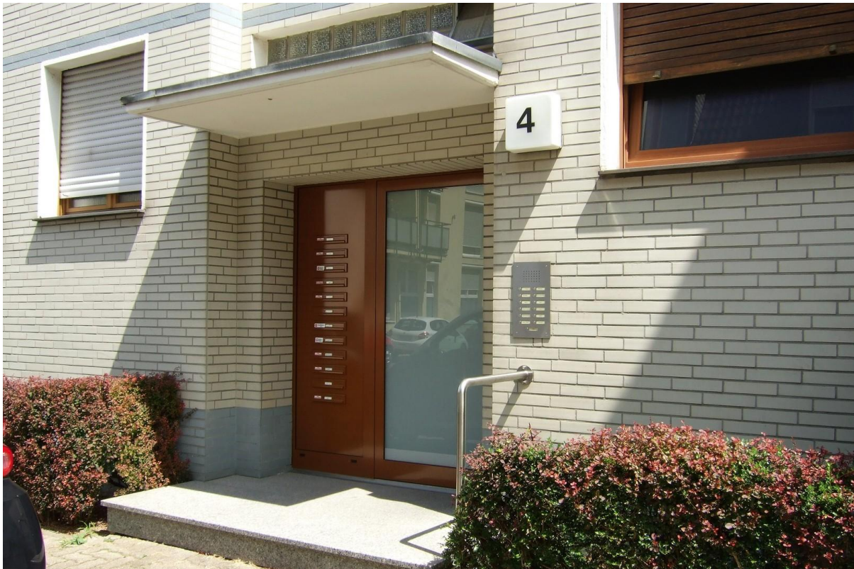
Hauseingang mit neuer Tür
