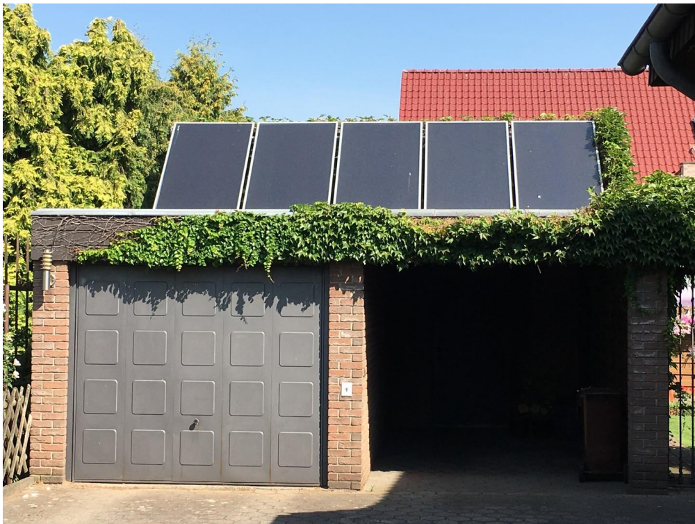
Garage mit Solaranlage
