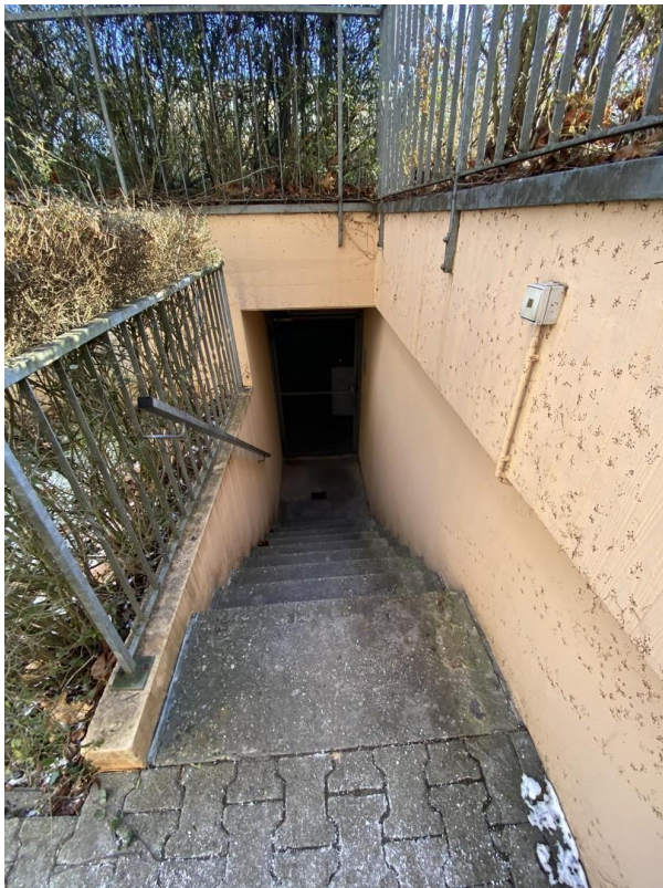
Zugang zur Tiefgarage
