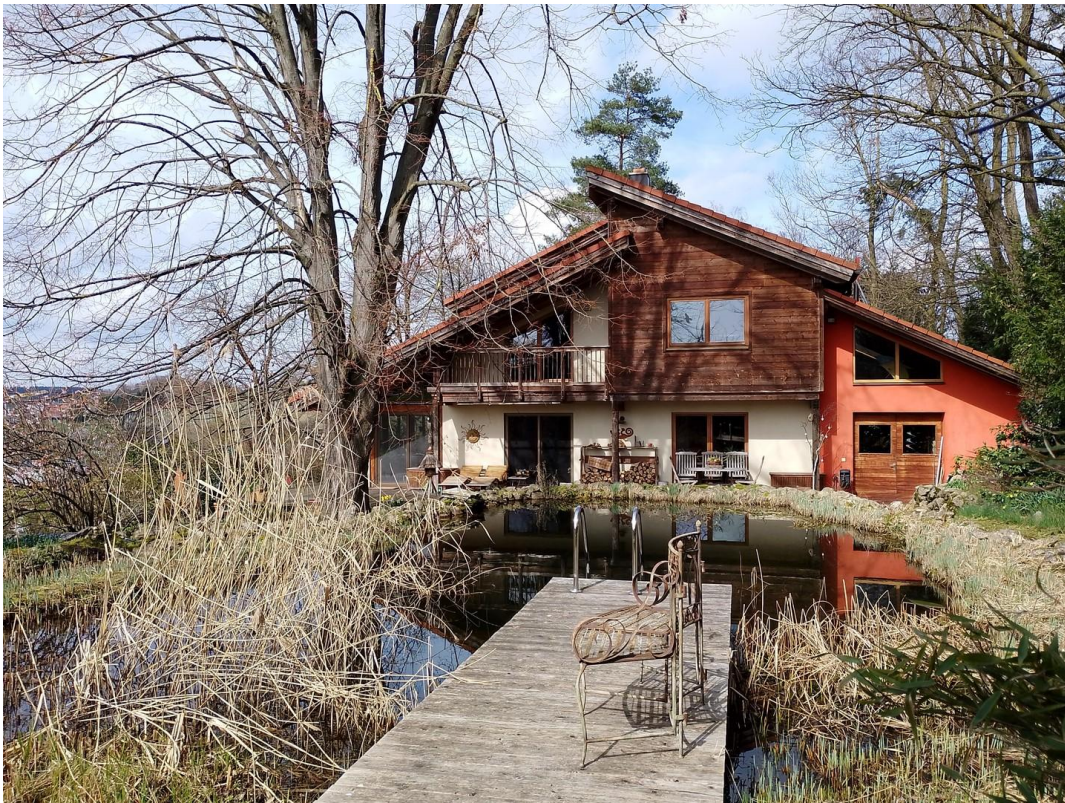
Südseite mit Schwimmteich
