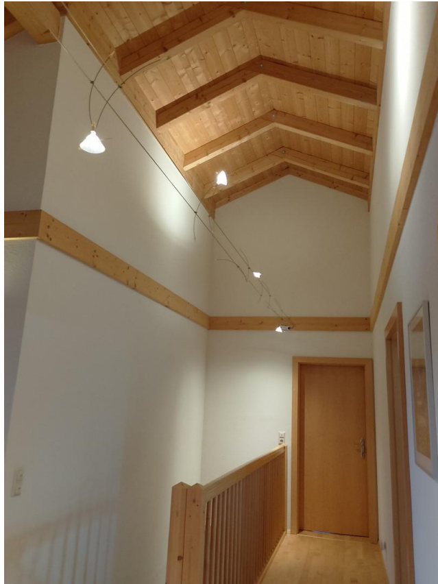
Sichtbalkendecke im OG
