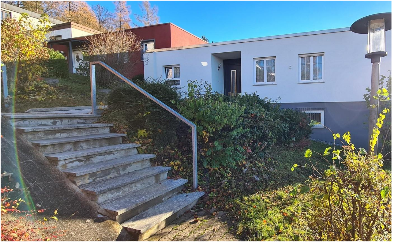
Zugang zum Hauseingang
