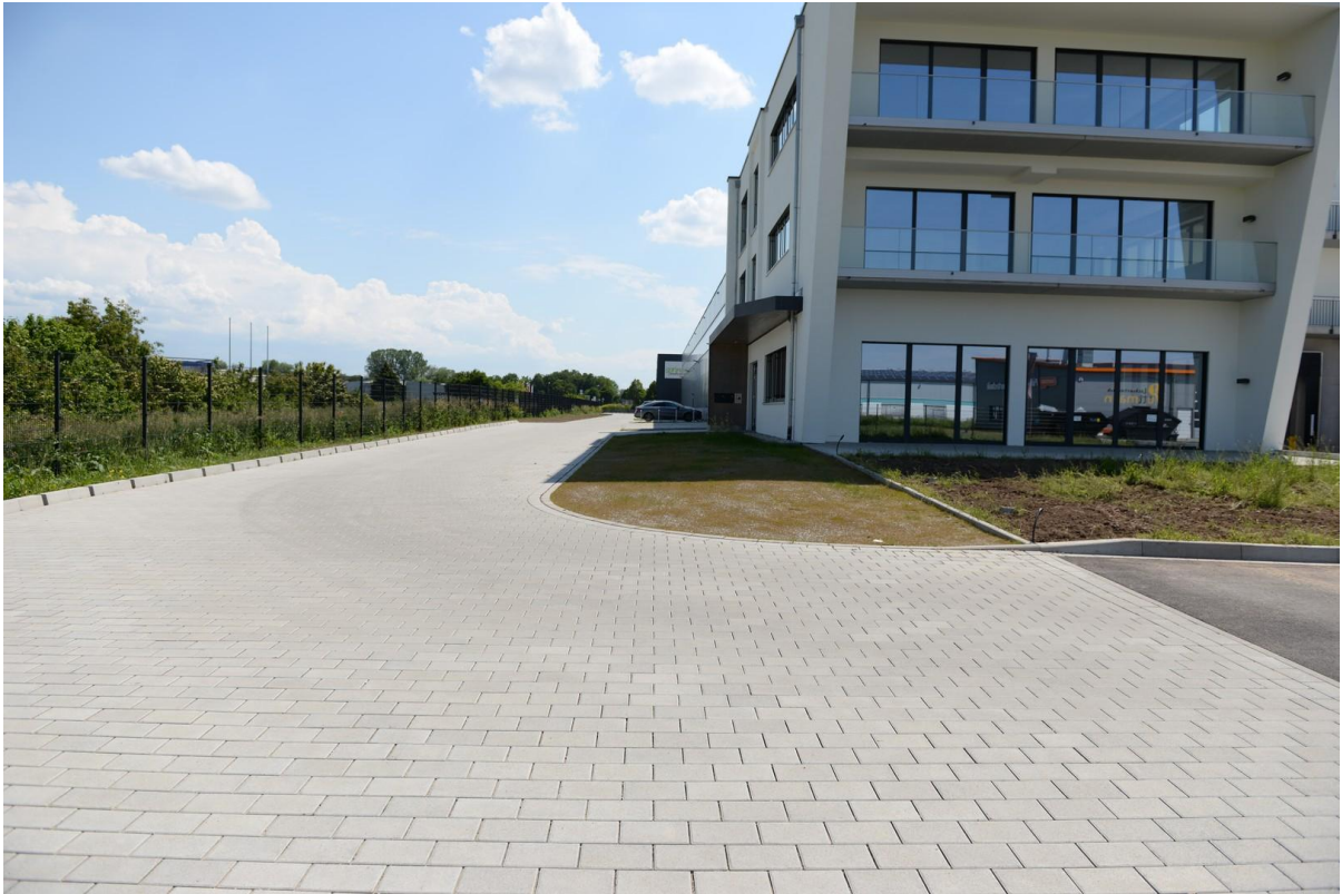
Zufahrt zum Bürogebäude
