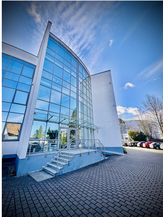
Gebäudeteil A (Eingang)
