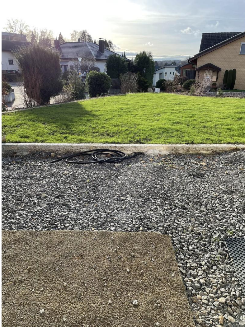
Terrasse ist fertiggestellt
