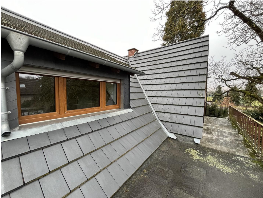
Neues Dach inkl. Gaube
