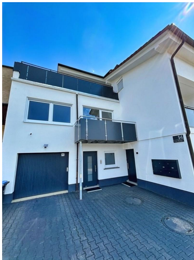
Hausansicht - Eingang rechts
