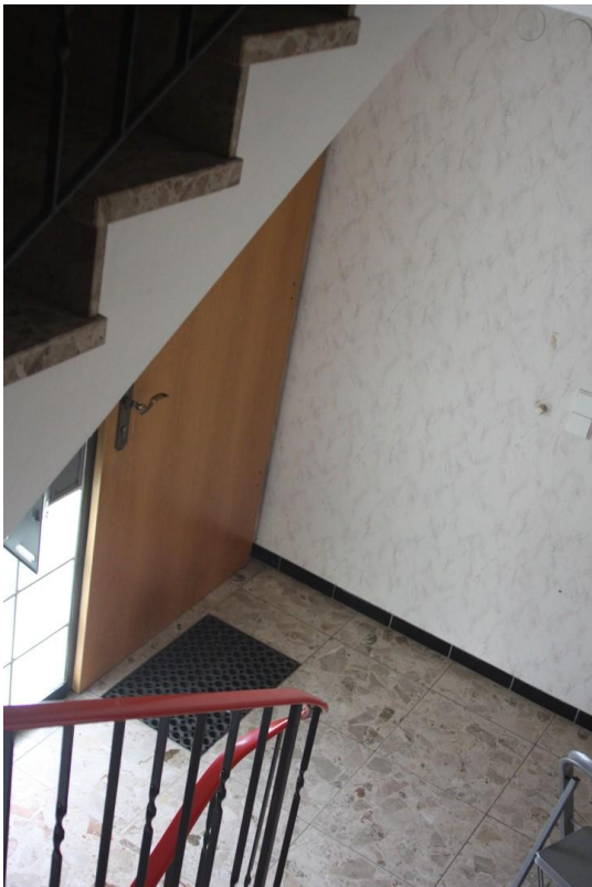
Helles Treppenhaus Eingang
