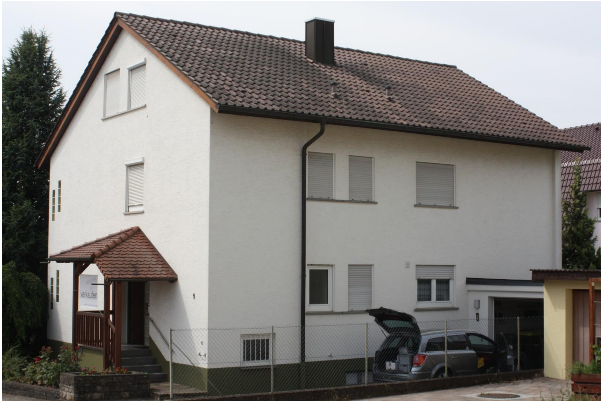
Ansicht Eingang Ost-N. Garage
