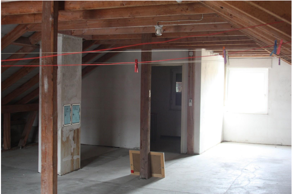
DG Blick Treppenhaus Ost
