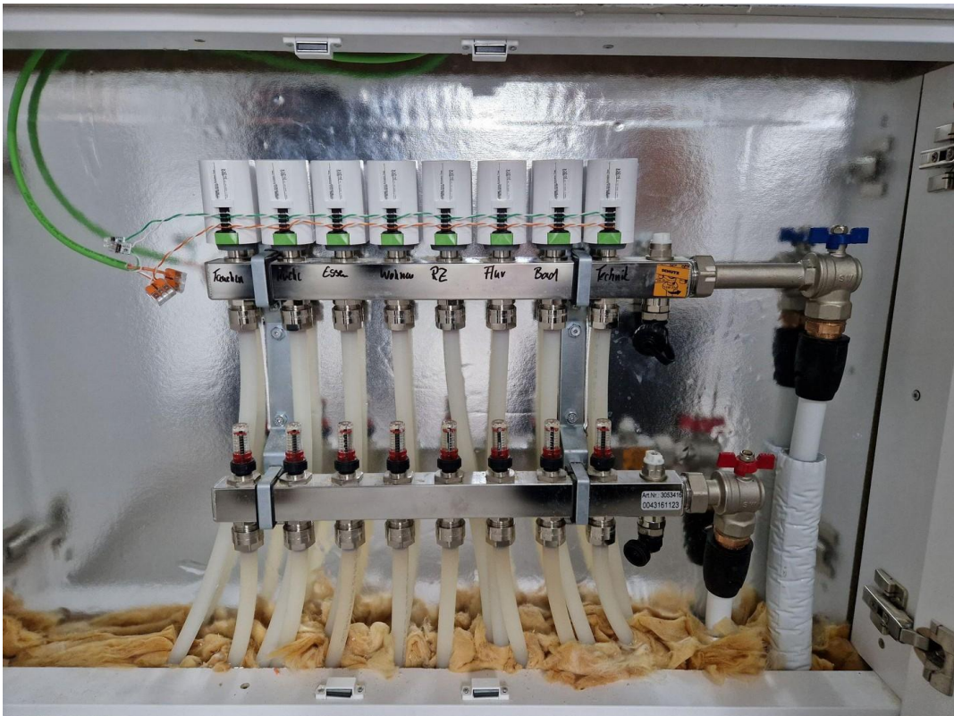
Heizkreisverteiler
