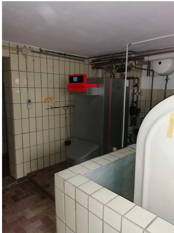
Heizraum / u. Werkraum
