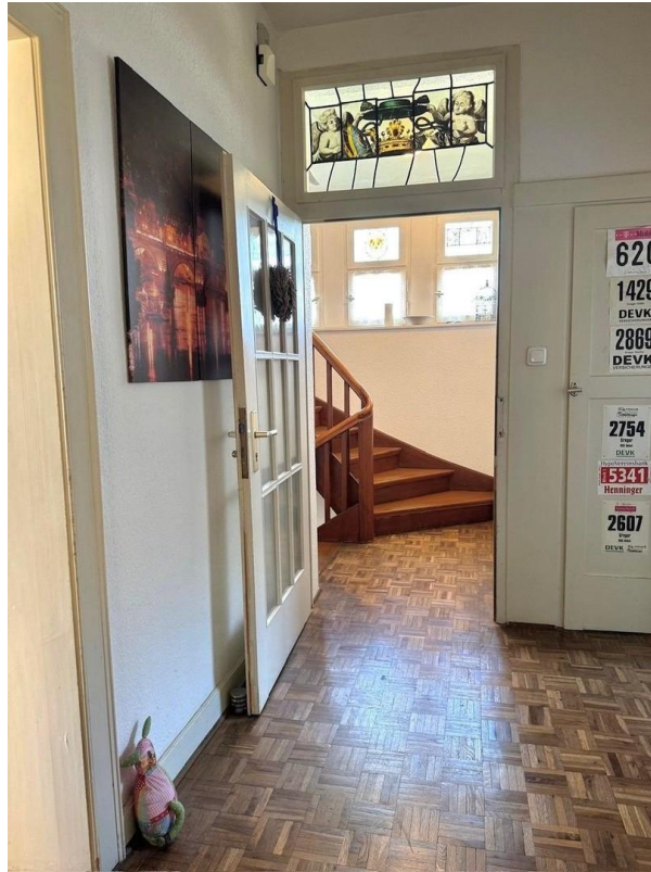
1.Etage Blick ins Treppenhaus
