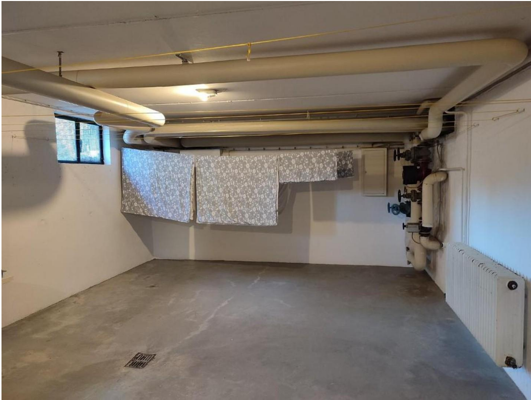
Trockenraum im Keller
