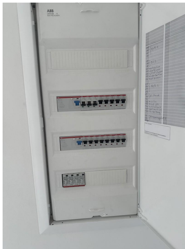
Elektrosicherungskasten
