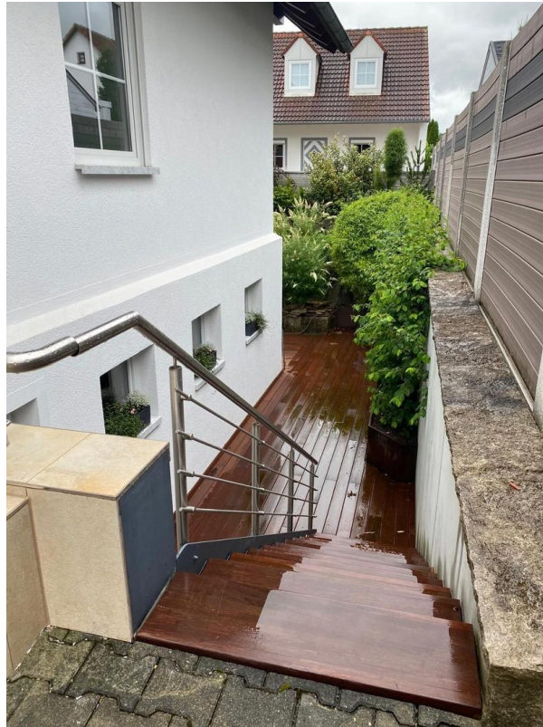
Abgang UG souterrain
