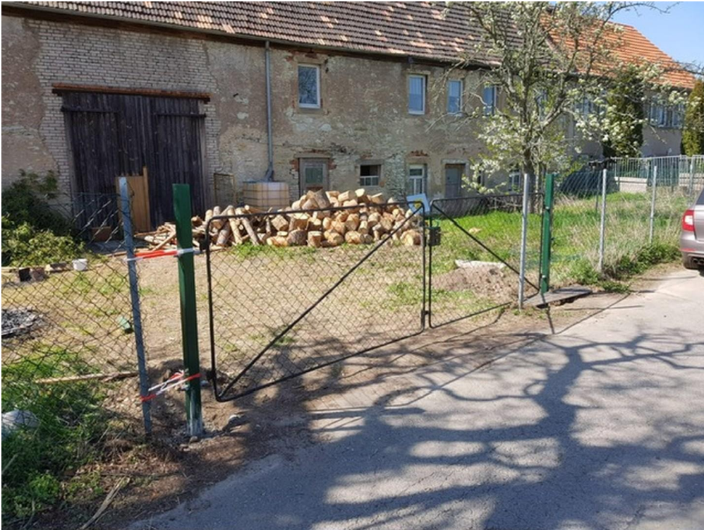
Ansicht mit Anbau rechts Nachb
