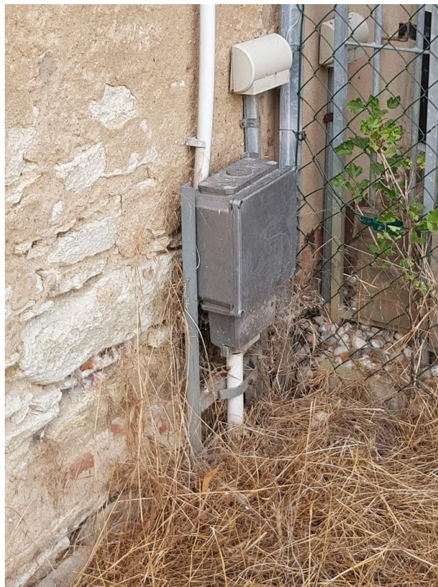
Hausanschluss Strom
