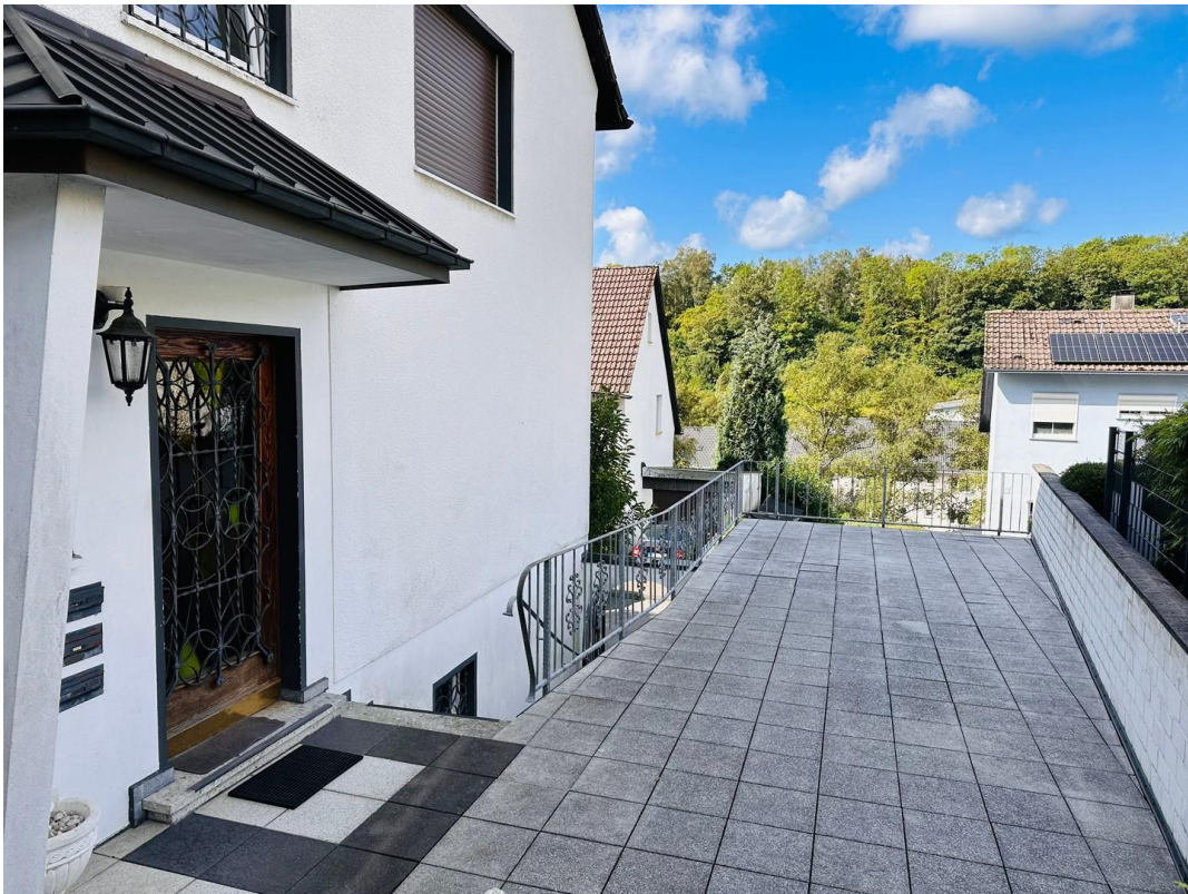
Terrasse oberhalb der Garage
