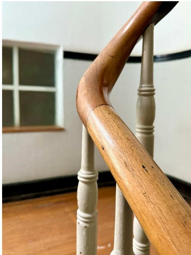
Detail histor. Treppenhaus
