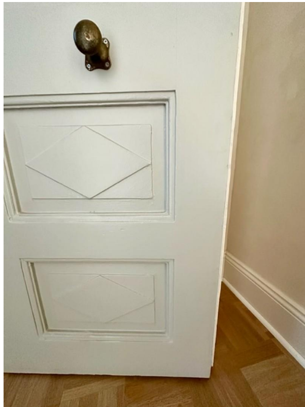
Detail historische Eingangstür
