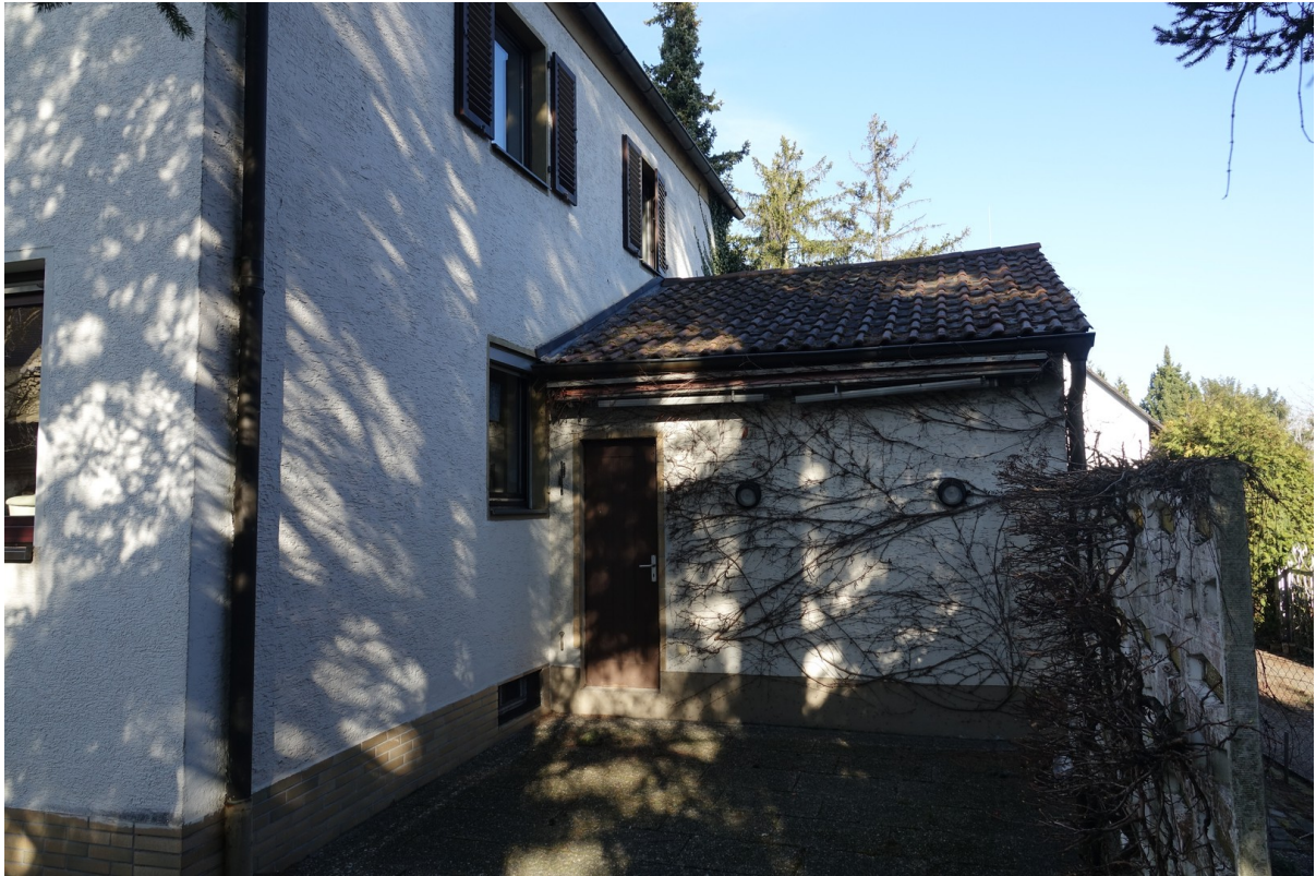
Garage über Garten erreichbar
