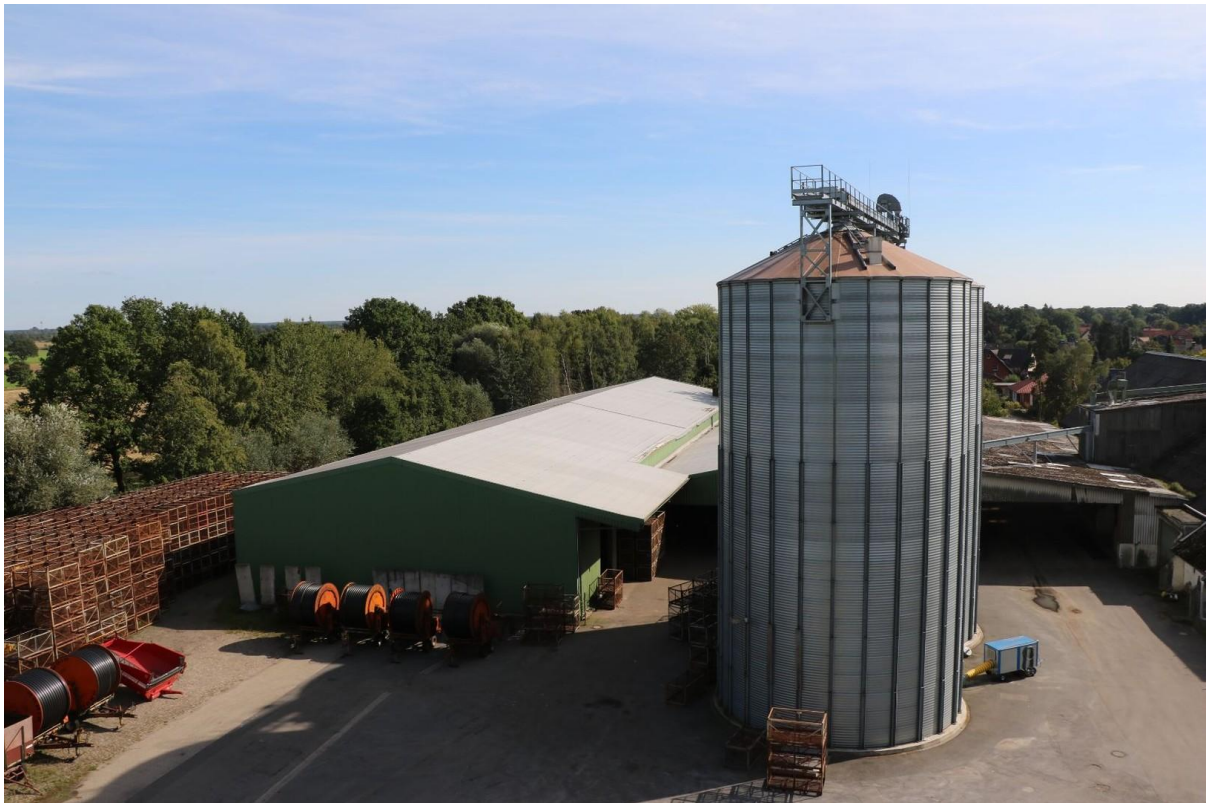
Silolanlage und Lagerhalle
