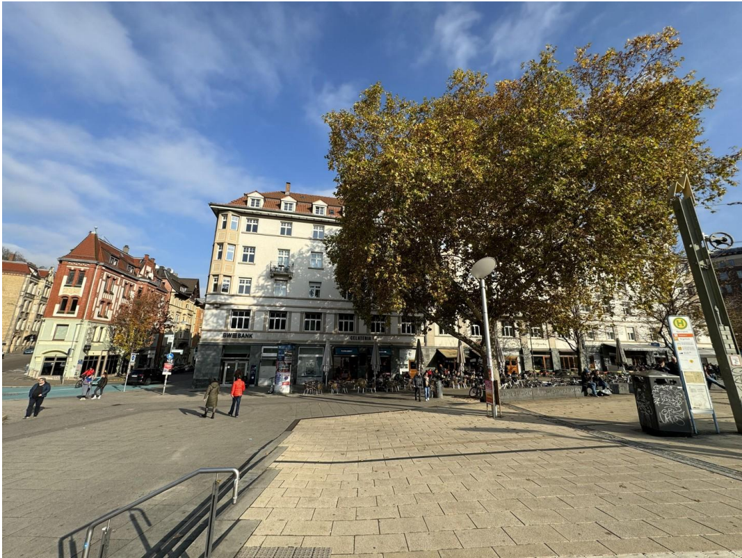
Blick v. Marienplatz aufs Haus
