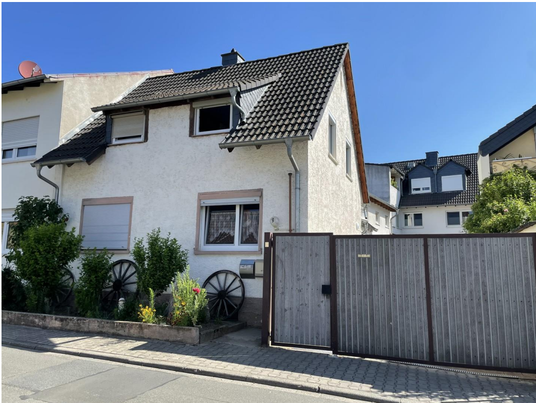
Blick von der Straße
